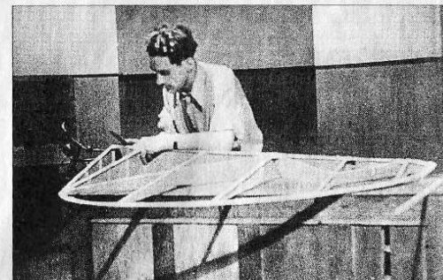
Eine der Heckflossen wird zusammengesetzt. Foto: privat
